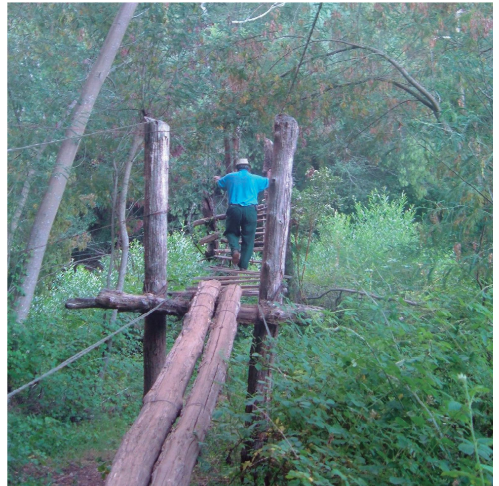
Puente colgante que conecta a la Comunidad con otros fundos aledaños
