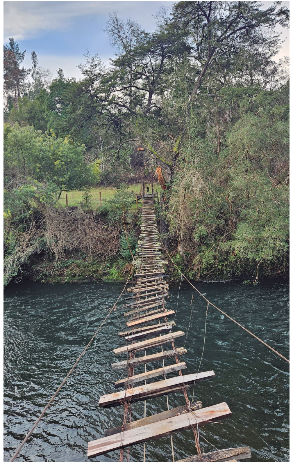
Puente colgante que conecta a la Comunidad con otros fundos aledaños
